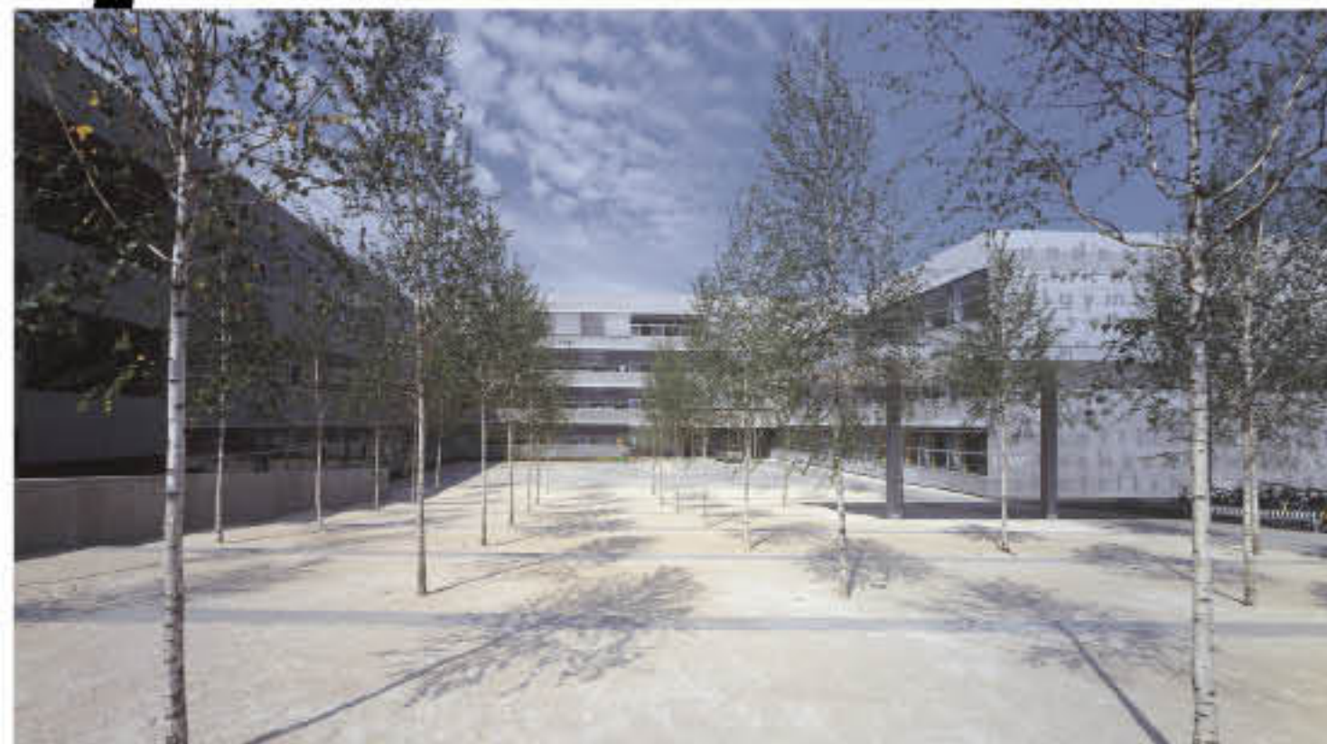
Die Architekten Riepl Riepl sorgten dafür, dass das Gebäude heute den Anforderungen einer Schule bestmöglich entspricht. Foto: RIEPL RIEPL Architekten
