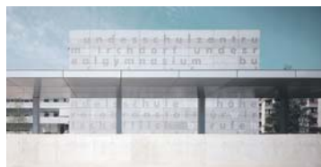
oben: neue Schule 1975 unten: nach dem Umbau 2003
